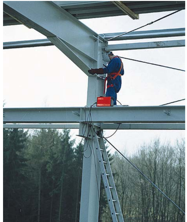
Рис. 20 Применение в качестве источника питания инвертора PICO 140 (4,6 кг/140 А) на строительной площадке
