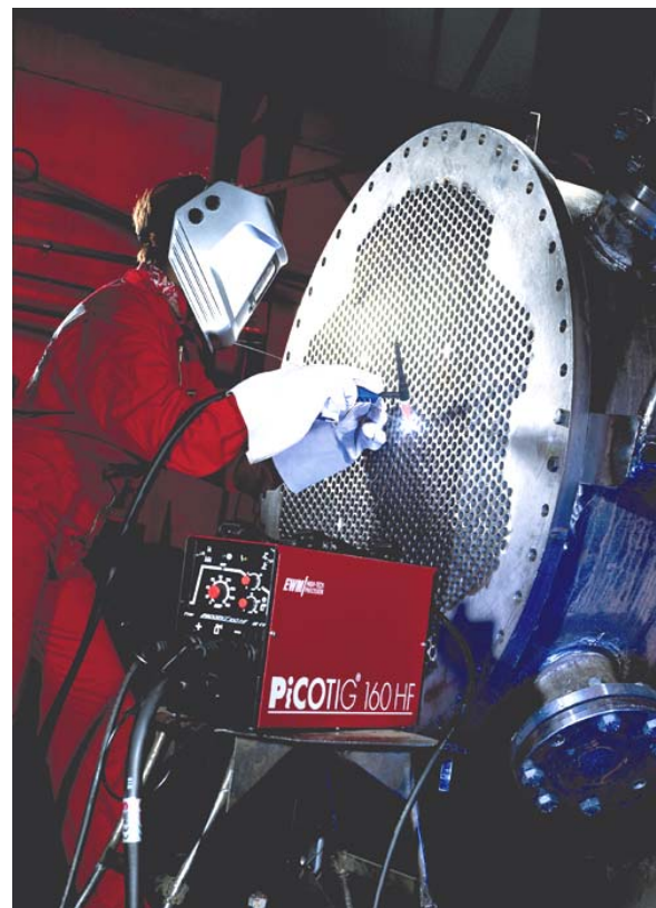
Рис. 32 Сварка ВИГ при приваривании труб к трубным решеткам
