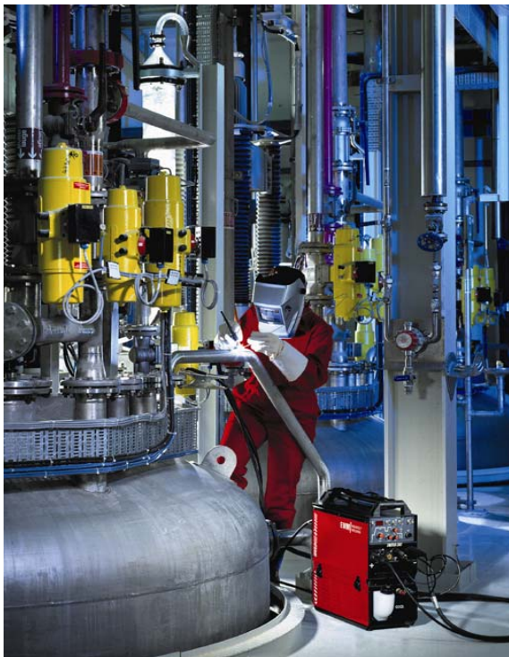
Рис. 30 TRITON 260 DC, сварка ВИГ трубопроводов
