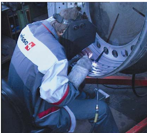
Рис. 31 Сварка ВИГ при ремонте деталей силового агрегата
